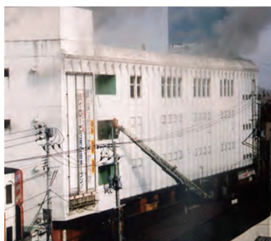
2006年3月諏訪町旧商業施設火災
