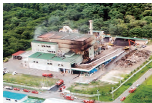
2006年9月和賀町産廃処理施設火災
