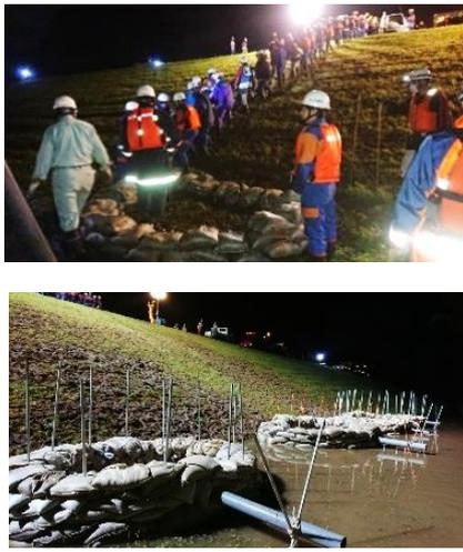
漏水の噴出口に土のうを積んで水をため、漏
