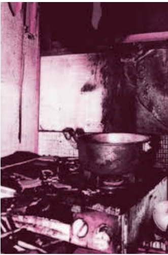
▲煮物を長時間加熱中、放置し、中身が燃え出して火災に。
